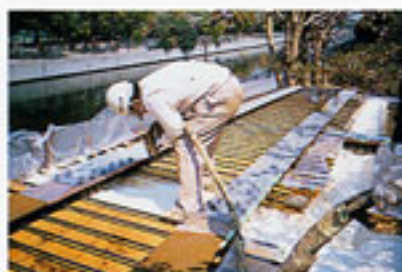
ウレタン施工
