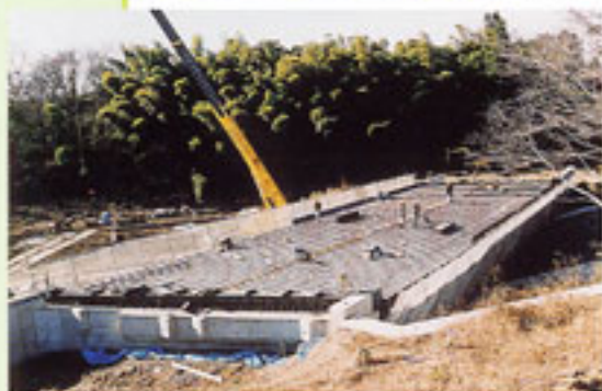
合成床版鋼製パネル架設完了
