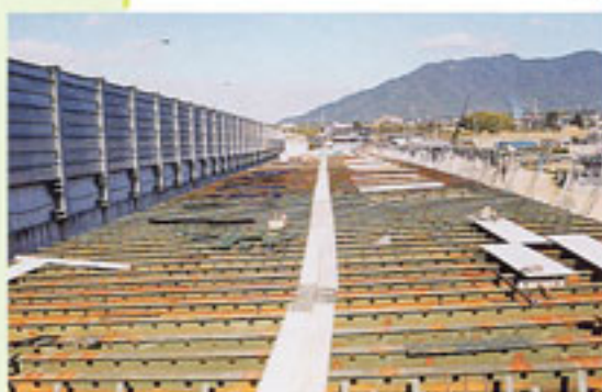
合成床版パネル架設完了
