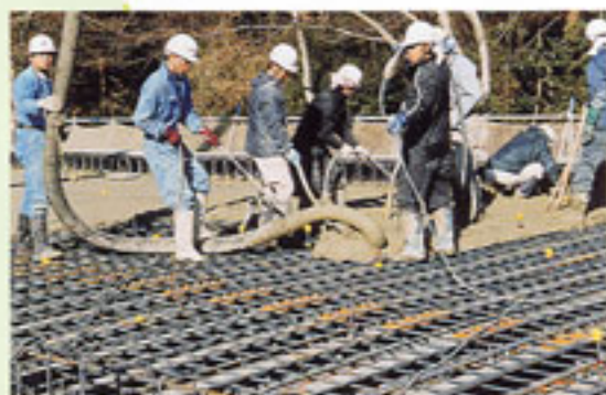
コンクリート打設作業
