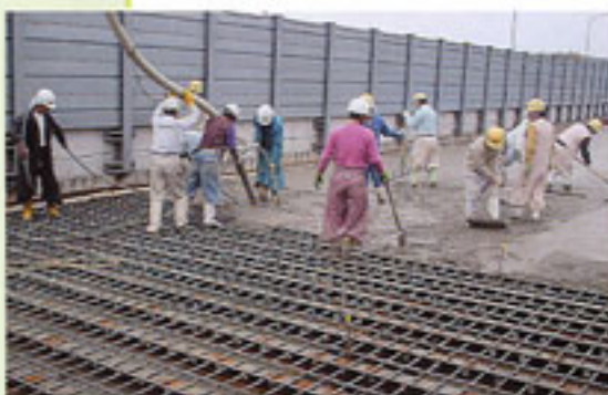
コンクリート打設作業
